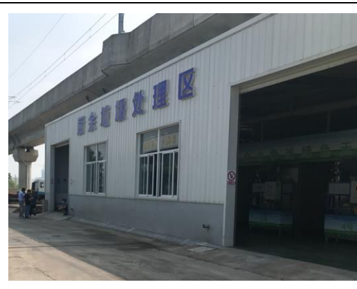
淳溪街道餐厨垃圾处理厂房（本项目）
